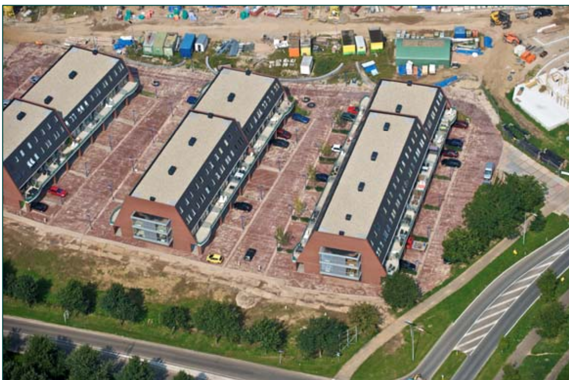
De Basiswoningen gezien vanuit Randweg Noord
