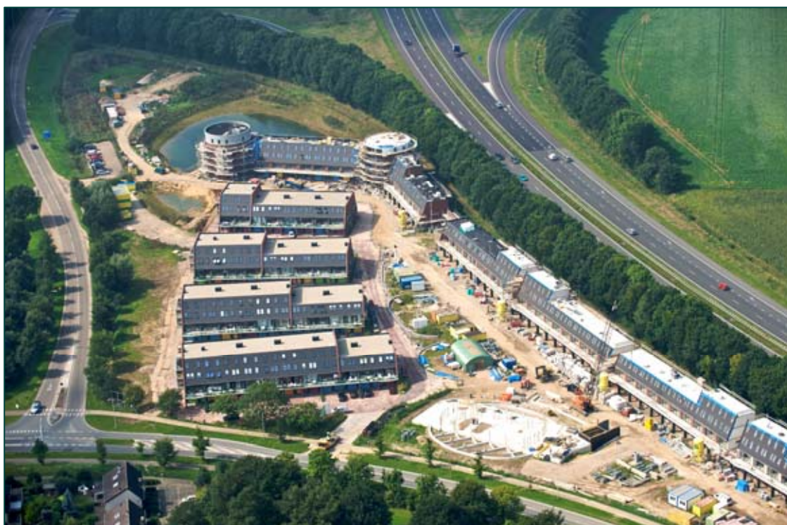
Donjon Noord, Donjon Zuid, Basiswoning en Schermwoningen gezien vanuit de Kraaijenberg
