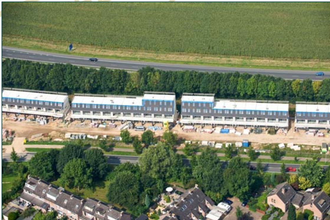
Voorzijde Schermwoningen gezien vanuit de Kraaijenberg
