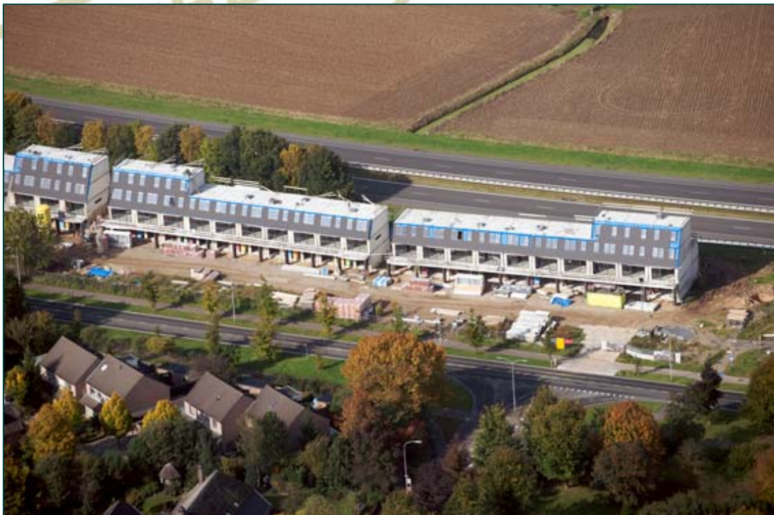
Voorzijde Schermwoningen gezien vanuit de Kraayenberg
