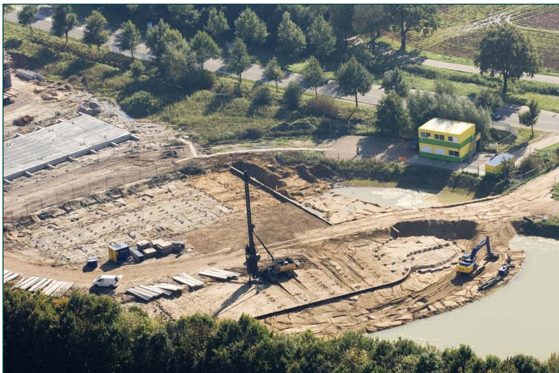
Locatie van de Donjon Noord en Zuid en de tussenliggende Schermwoningen gezien vanuit de A 326
