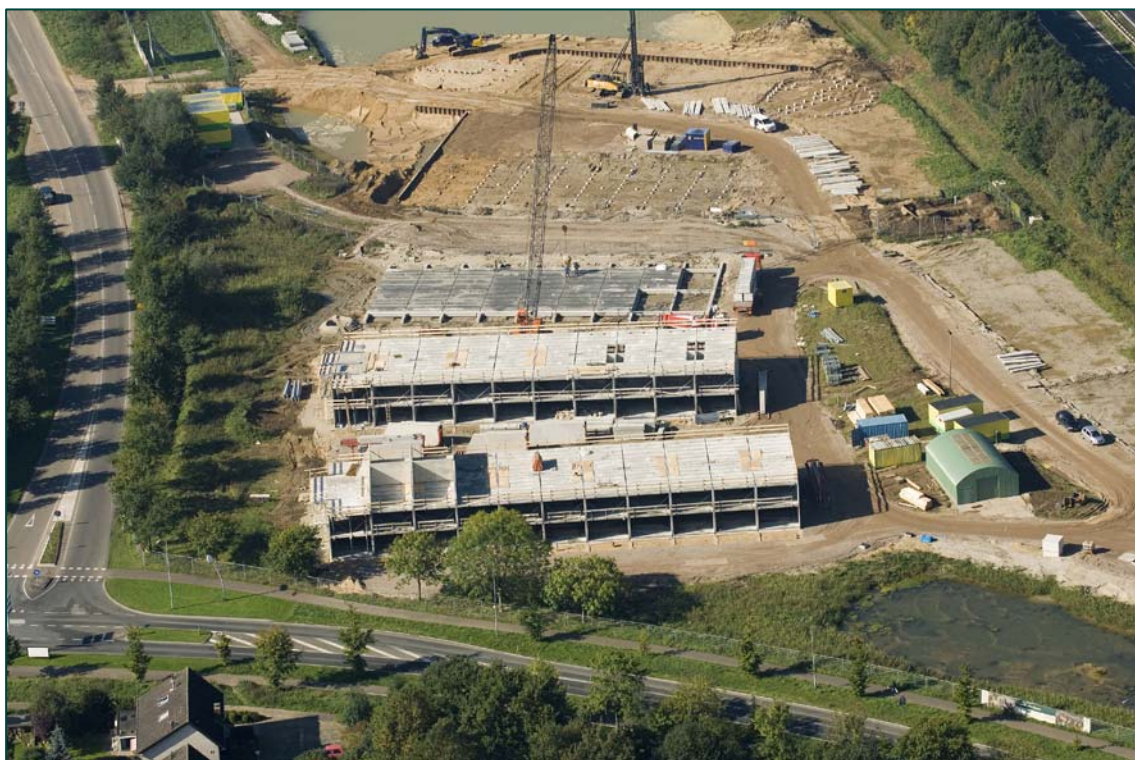
De eerste Basiswoningen gezien vanuit de Kraaijenberg
