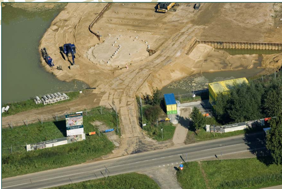
Markering van de plek van de Donjon Zuid en daarnaast liggende Schermwoningen
