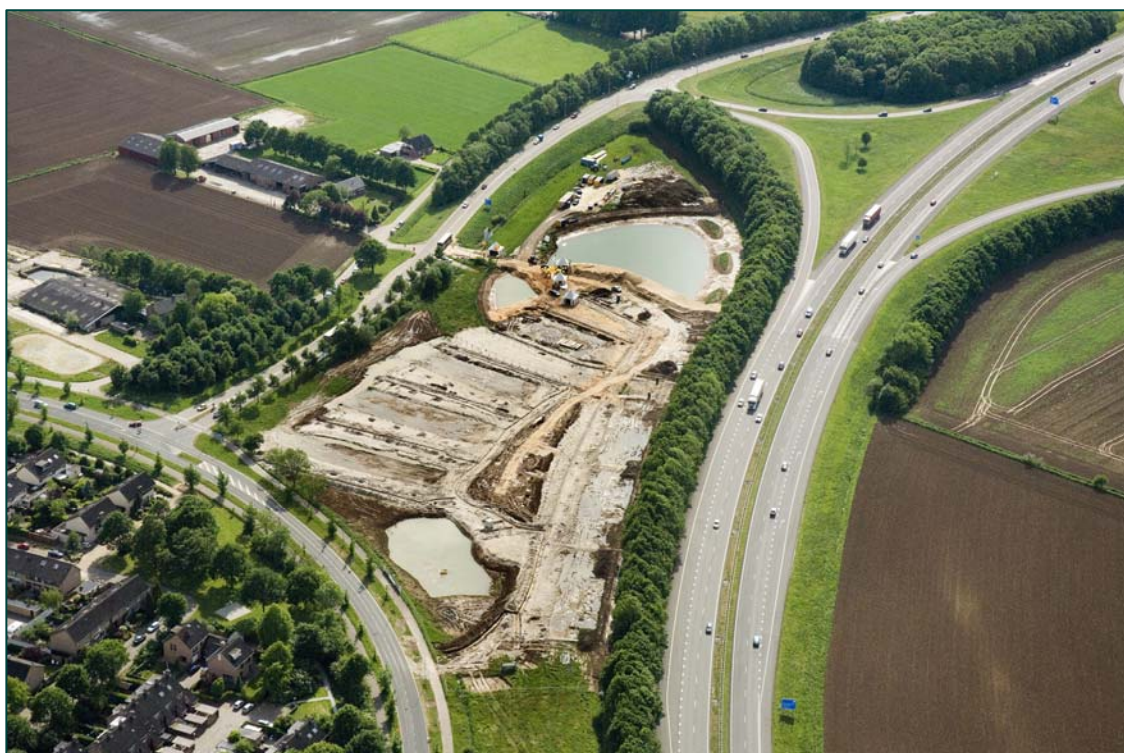
Plangebied gezien vanuit Kraaijenberg
