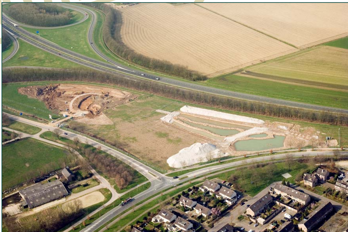
Plangebied gezien vanuit Kraaijenberg
