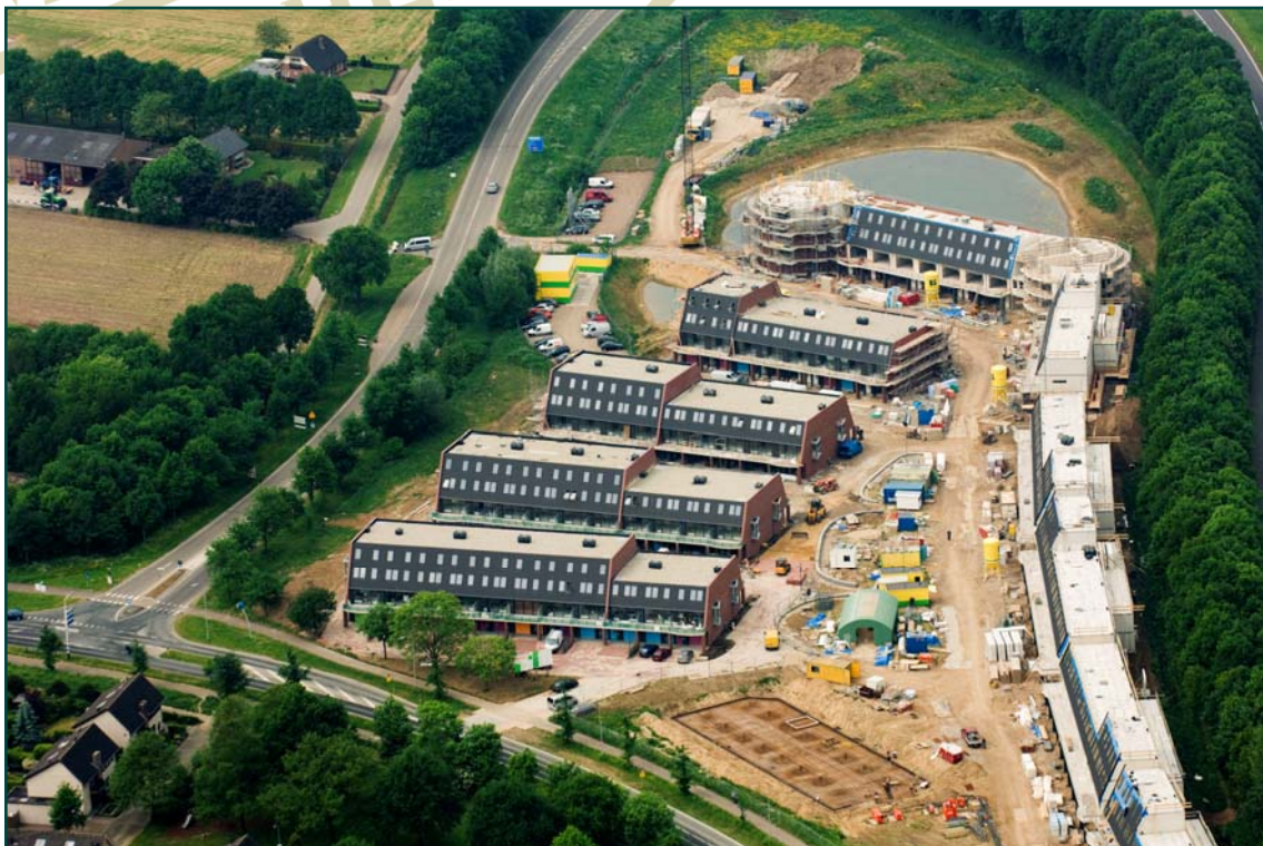
Basiswoningen, Schermwoningen, Donjon Noord en Zuid gezien vanuit de Kraaijenberg
