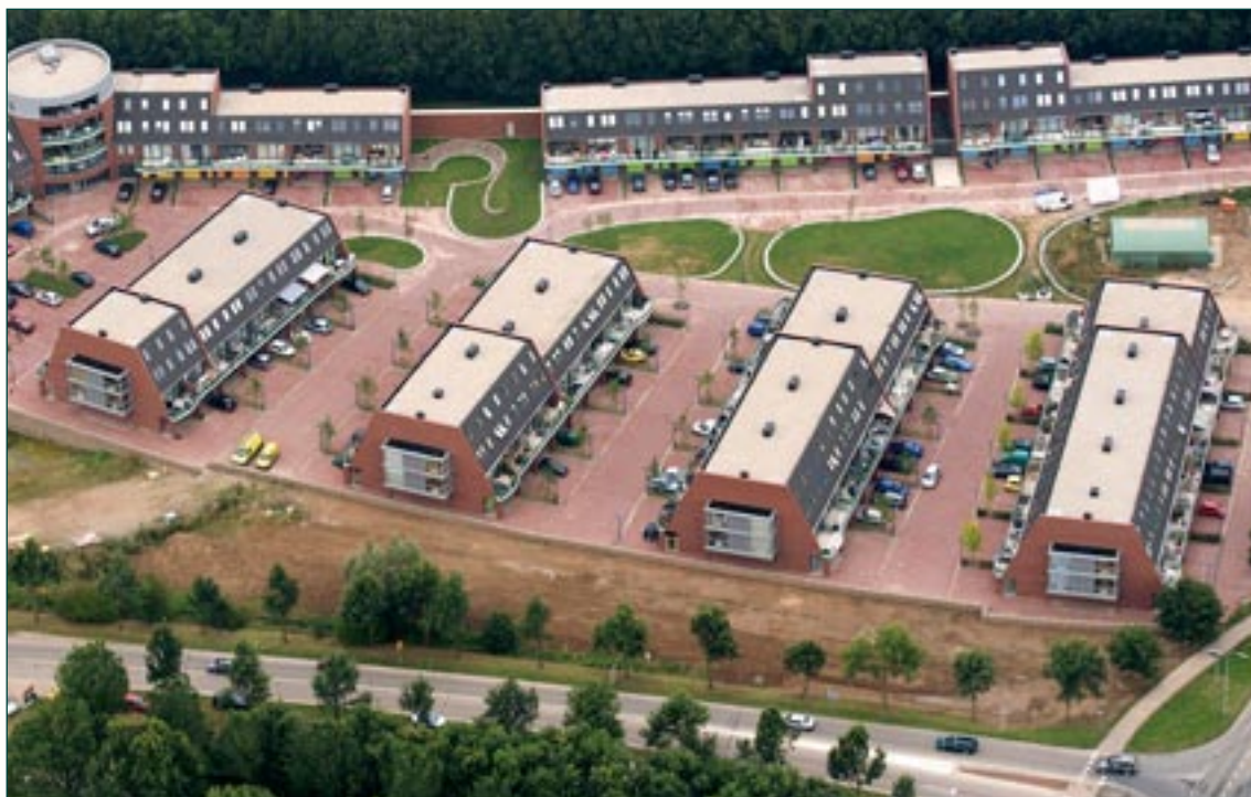
Basiswoningen en Schermwoningen gezien vanuit Groenestraat
