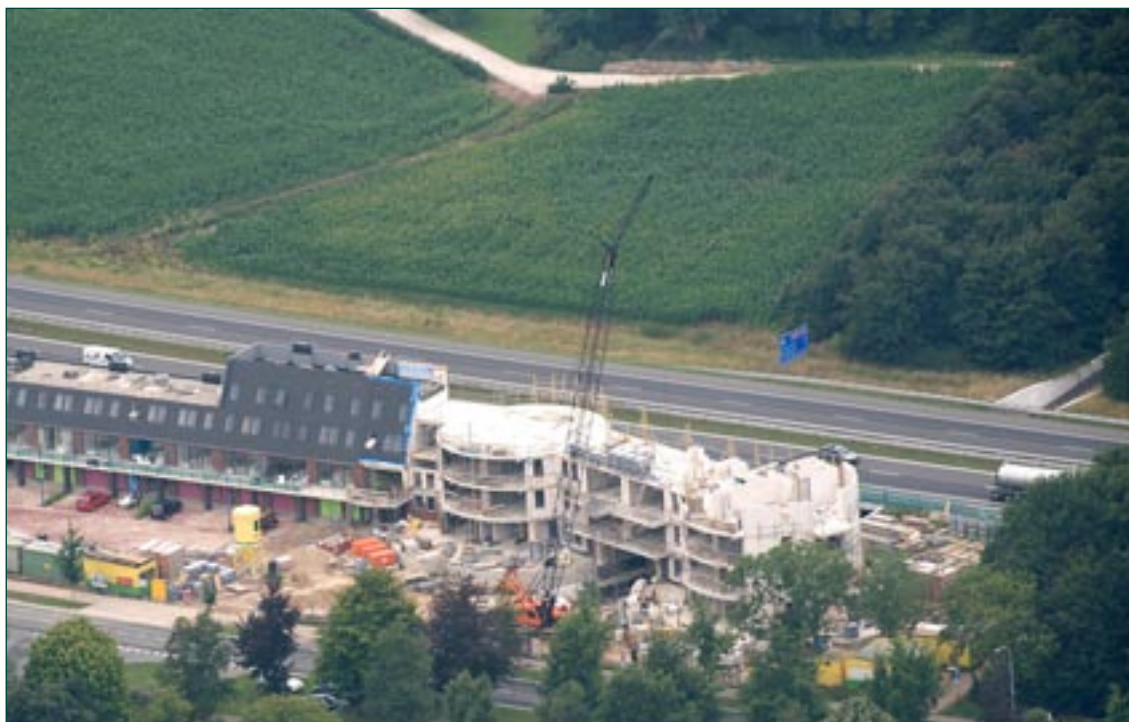
Poort van Leur in aanbouw gezien vanuit Randweg Noord
