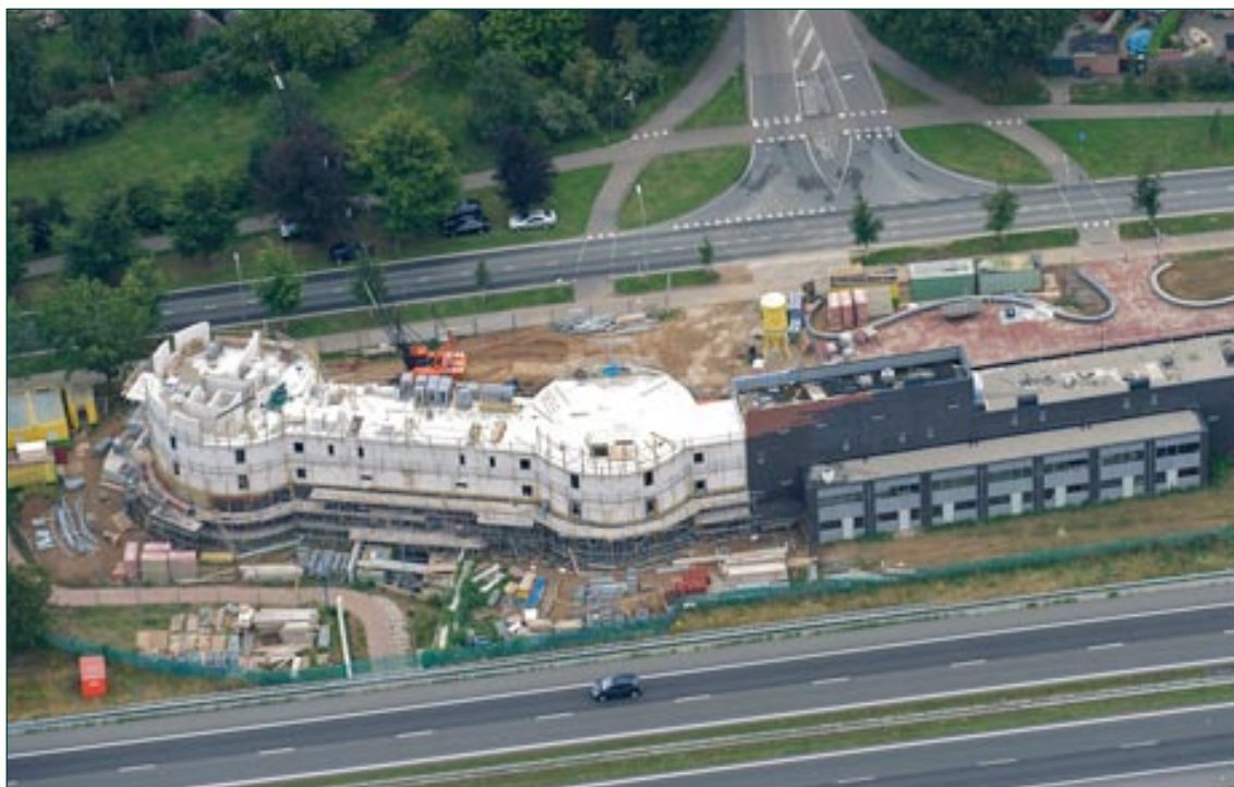
Poort van Leur in aanbouw, gezien vanuit A326
